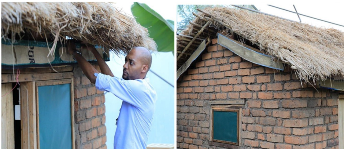
Figura 10. Instalação das faixas de juta impregnadas com o piretróide Transflutrina nas casas da área de semicampo do Ifakara Health Institute, Tanzânia. Adaptado de Mmbando, et al. 102 .
